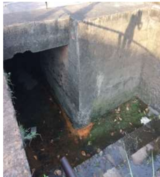
Figura 13 – Canal onde percorre o Córrego Afonso XIII
