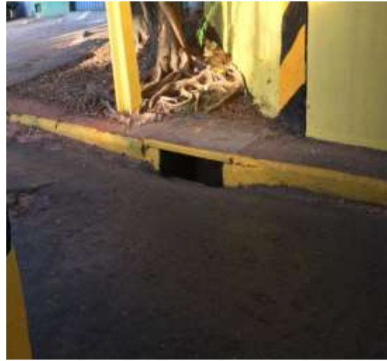
Figura 18 – Boca de lobo na Rua Lélío
