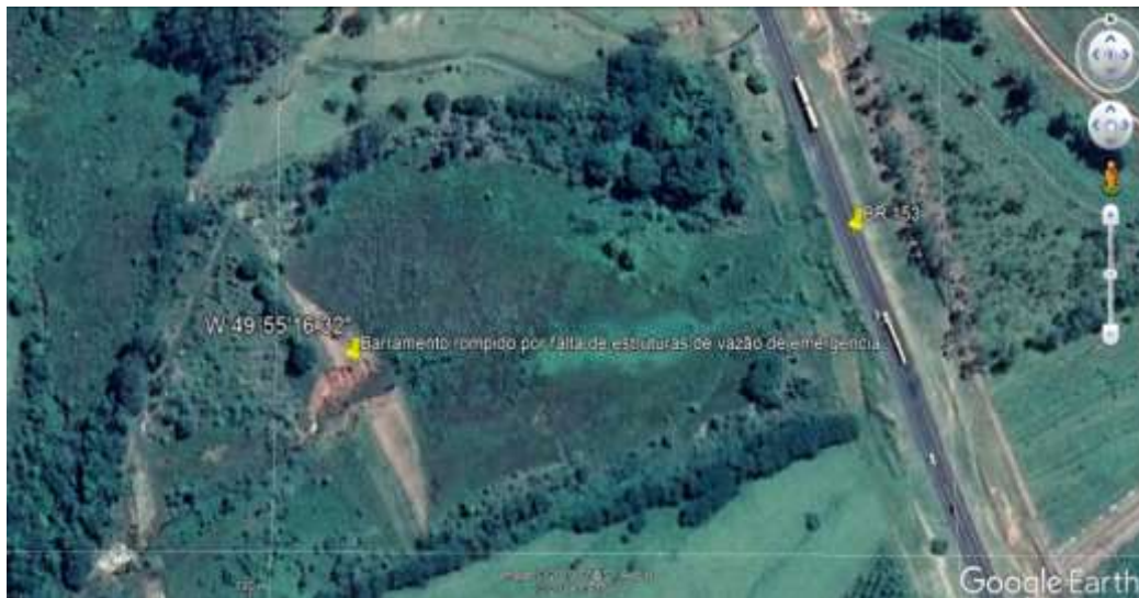
Figura 18 - Barramento rompido por falta de estruturas de vazão de emergência
