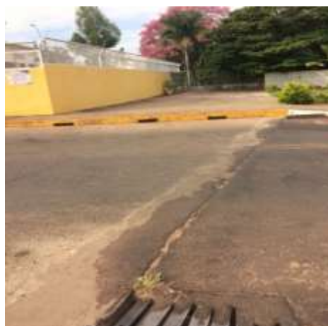
Figura 8 – Canal Córrego Afonso XIII
