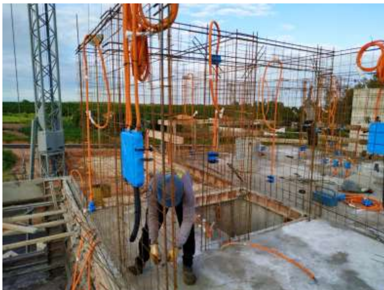
Figura 5: Montagem da armação de parede e instalações elétrica
