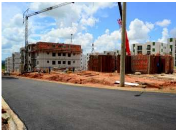
Figura 9: Forma de Aço, montagem com auxílio de Grua
