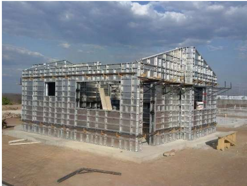
Figura 10: Estrutura Forma de Alumínio
