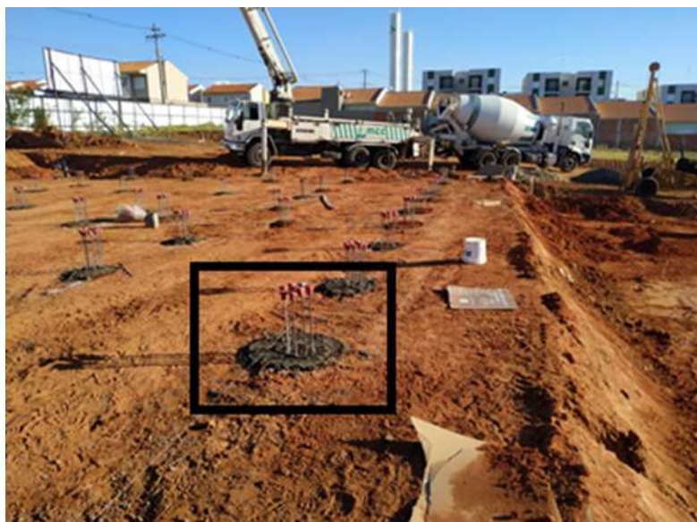
Figura 3: Estacas concretada
