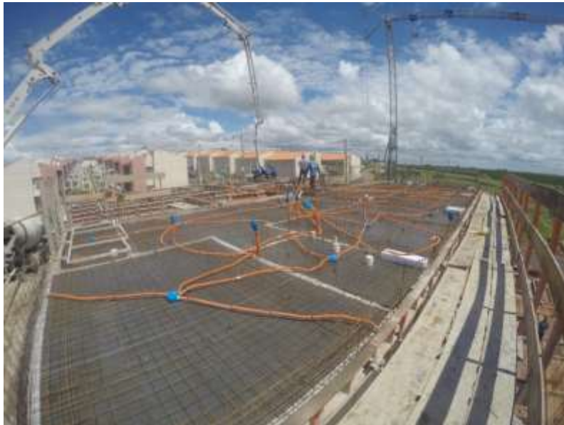
Figura 6: Instalações elétrica e Concretagem da Laje
