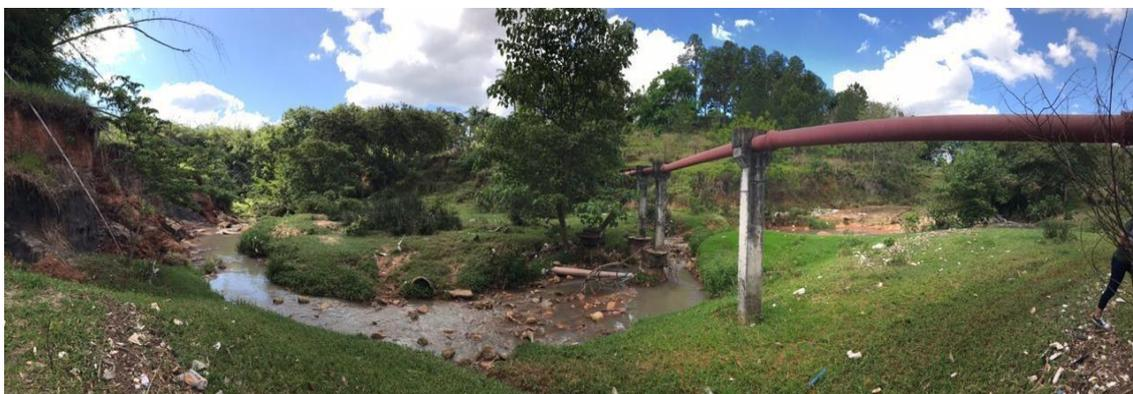
**Foto 13** – Área de inundação e estrutura da rede de esgoto sofrendo processo de erosão (14 de out. de 2018)
