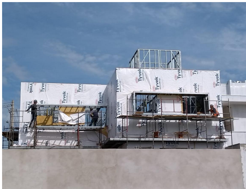
Figura 4 - Aplicação de placas OSB para fechamento
