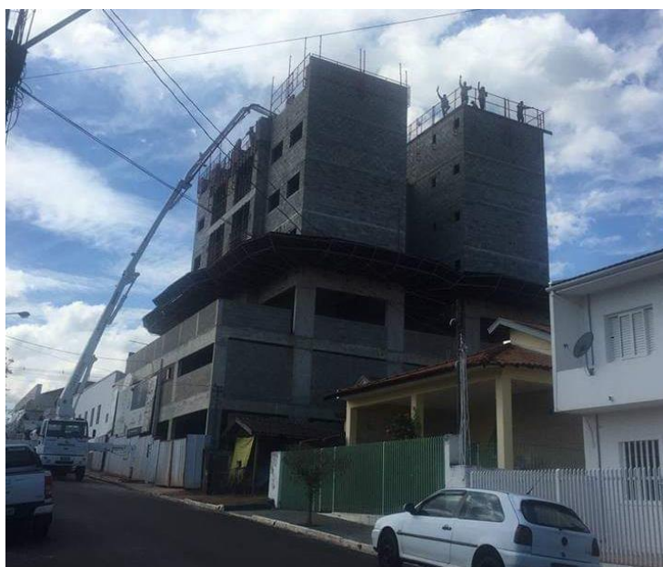
Figura 4 – Elevação da alvenaria estrutural
