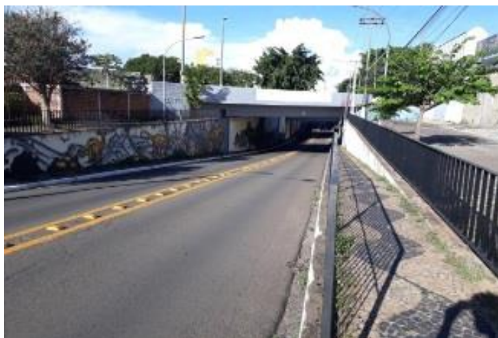
Figura 13 - Avenida Brigadeiro Eduardo Gomes. Plano de drenagem ineficiente (boca de lobo fora de nível); pavimento e sarjetas impermeáveis. Falta de drenagem adequada.
