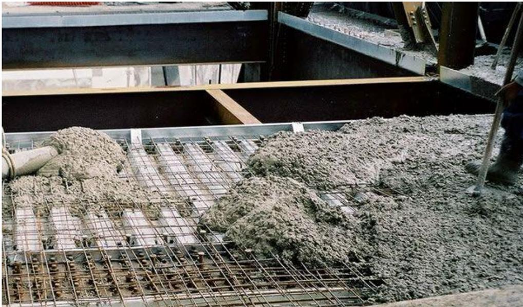
**Fonte:** Tèchne (2014) Lajes em *Steel Deck*
