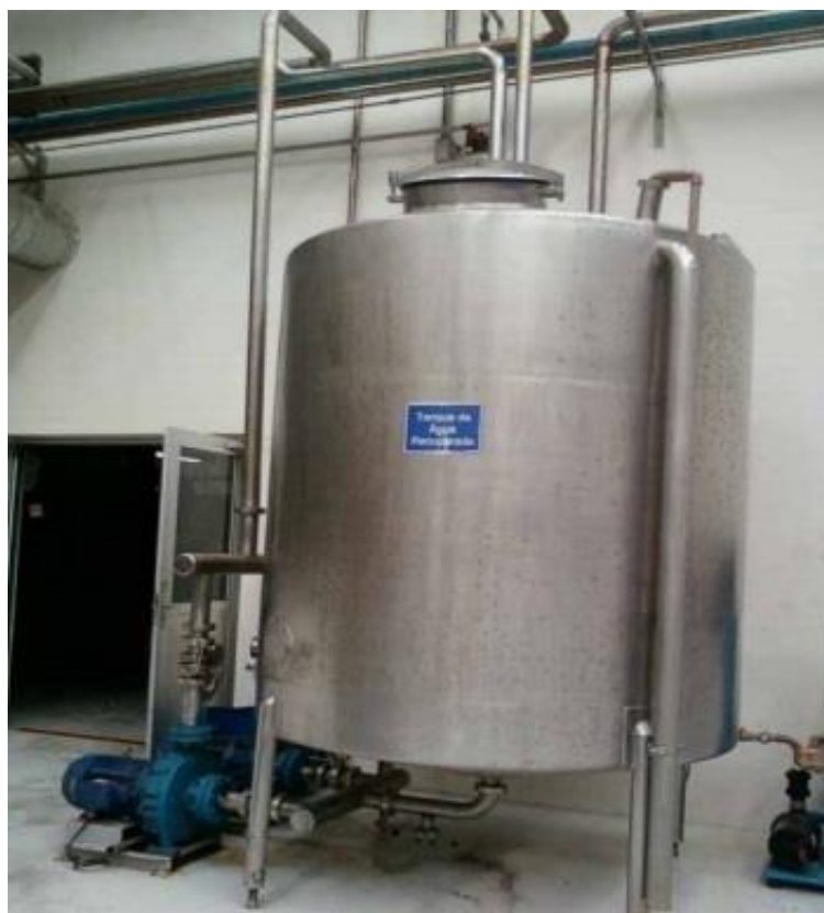
Figura 13- Sistema de reaproveitamento de água do rinser de garrafas pets
