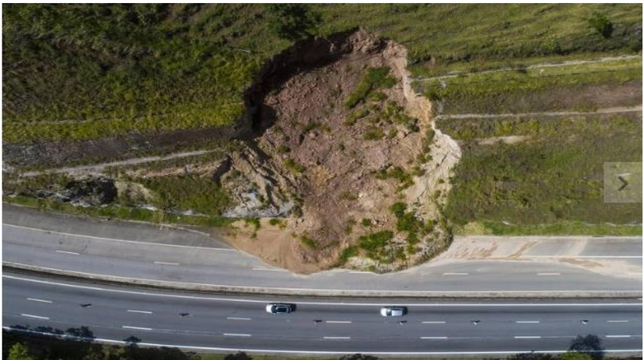
Figura 3 - Deslizamento na Rodovia dos Tamoios sentido litoral / 21 de dezembro de 2018.
