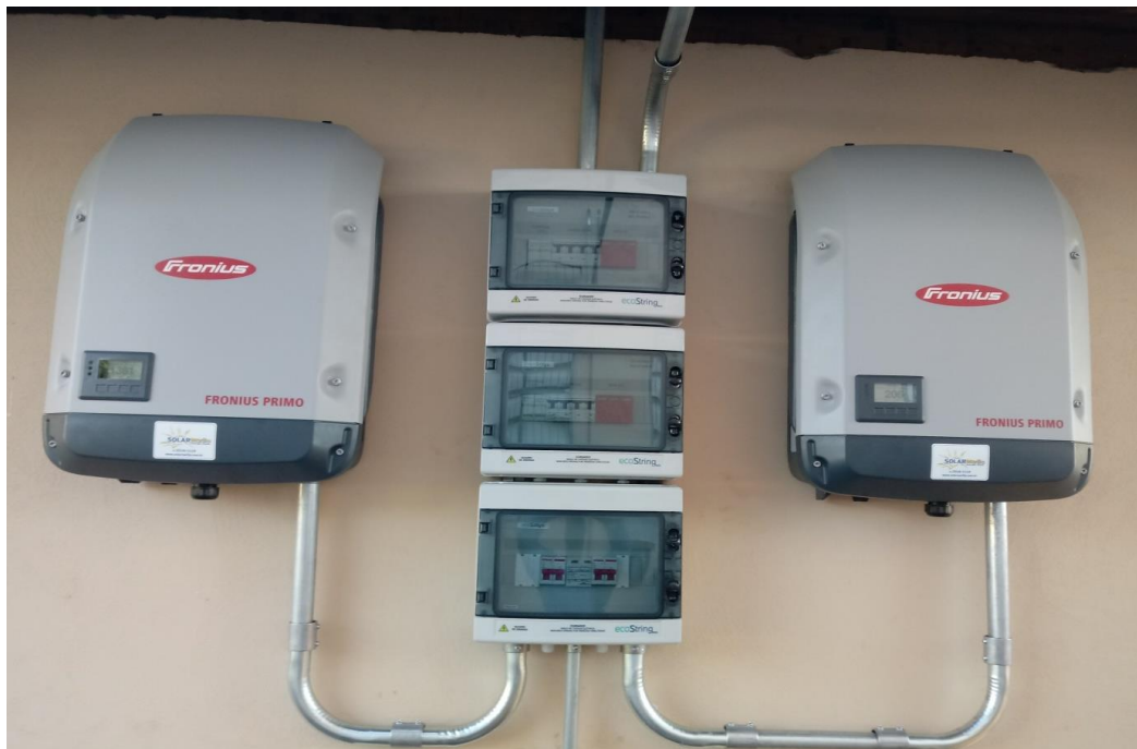
Figura 2 – Componentes do sistema fotovoltaico on grid .
