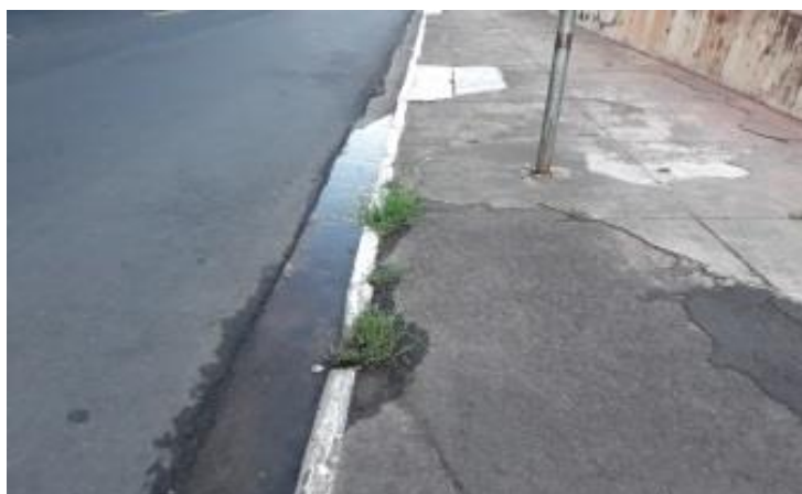
Figura 13 - Avenida Brigadeiro Eduardo Gomes. Plano de drenagem ineficiente (boca de lobo fora de nível); pavimento e sarjetas impermeáveis. Falta de drenagem adequada.
