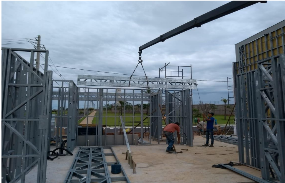
Figura 3 - Estrutura em perfil de aço galvanizado
