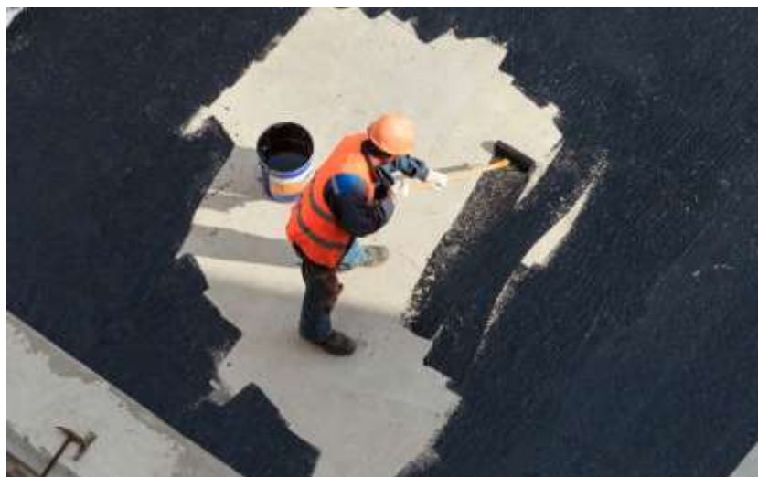
Figura 3 – Aplicação do primer asfáltico
