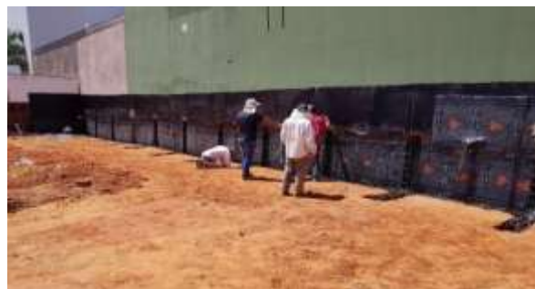
Figura 4 – Início da aplicação da manta
