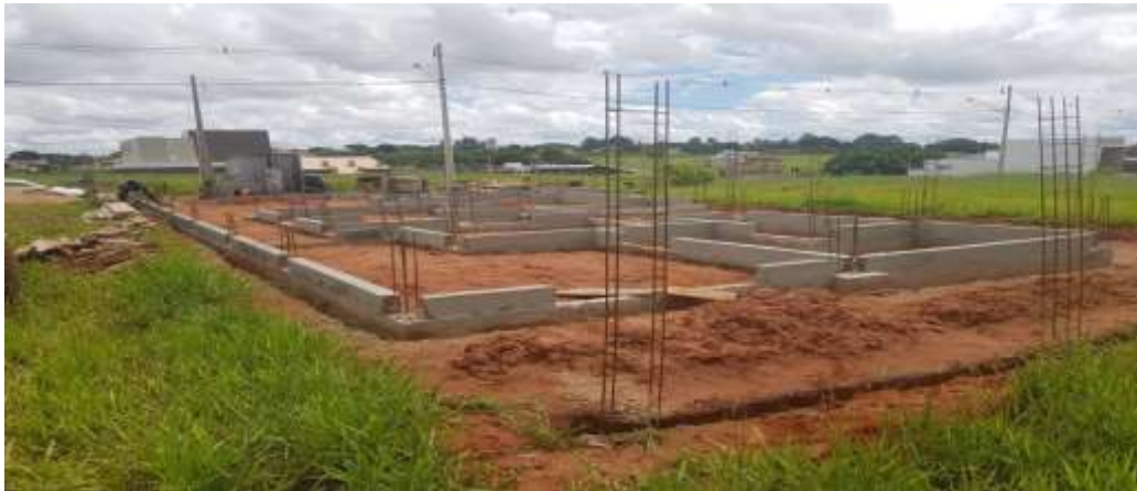
Figura 7 – Baldrame impermeabilizado
