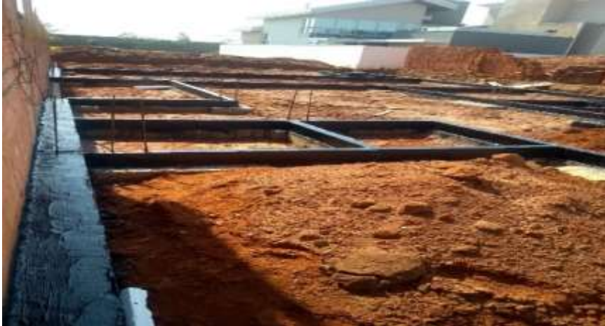
Figura 11 – Baldrames com Vedapren
