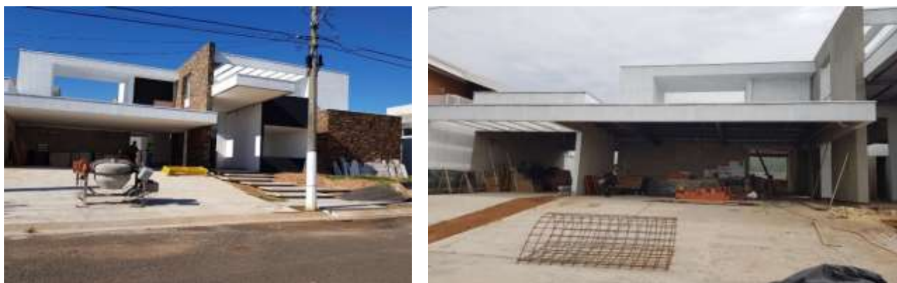
Figura 9 – Paredes com Vedapren
