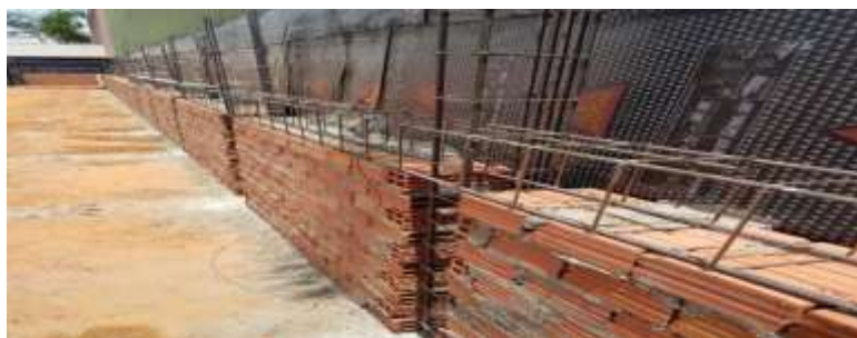
Figura 5 – Execução do muro
