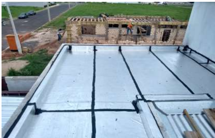
Figura 12 – Laje impermeabilizada com manta
