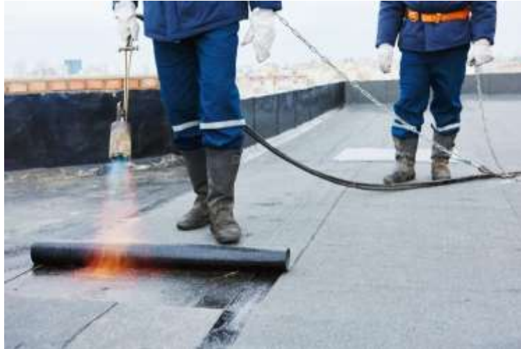
Figura 2 – Aplicação de manta asfáltica
