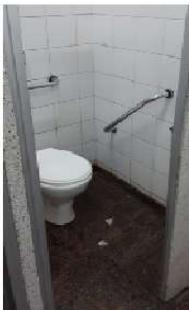
Figura 13 – Foto do banheiro PNL
