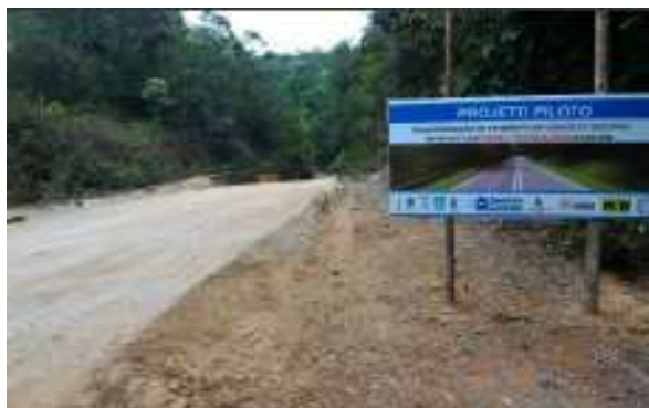
Figura 3 - Aspecto final do trecho no 1º dia.
