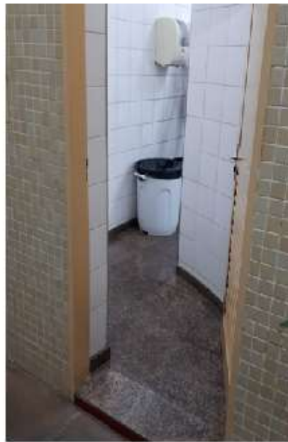
Figura 11 – Acesso ao banheiro masculino e feminino
