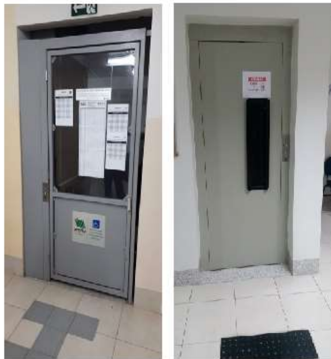
Figura 18 – Foto dos elevadores de acesso a sala de aulas e laboratórios
